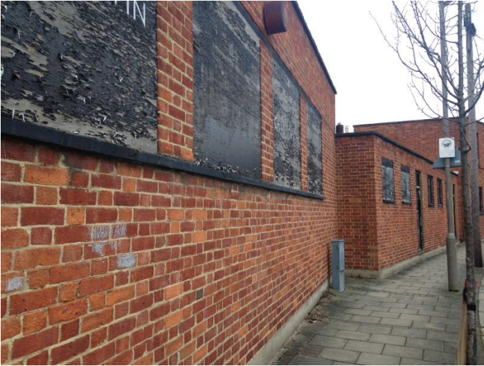
Units on Lydden Grove
